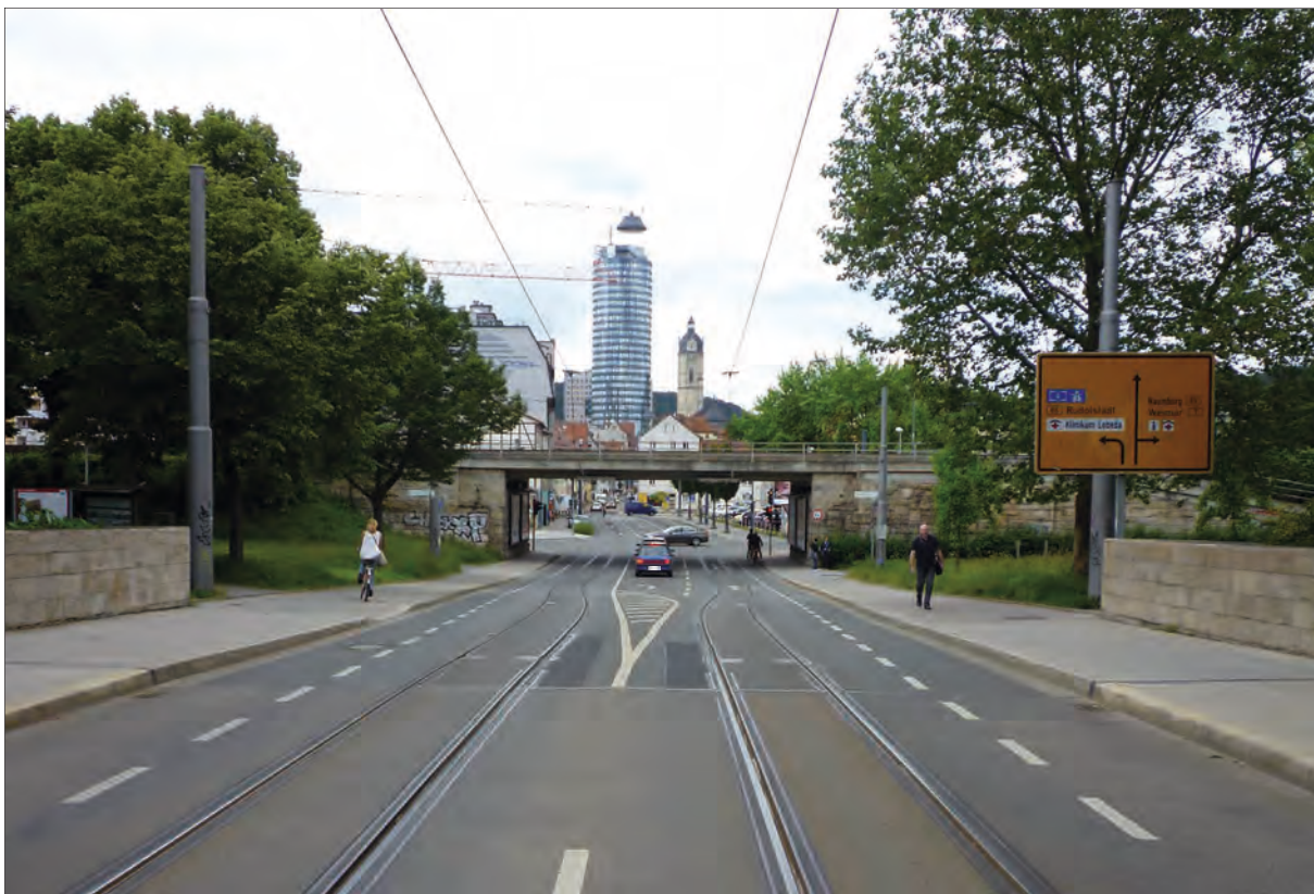
B Straßenansicht Camsdorfer Brücke, Blickrichtung Ost, Bestand
