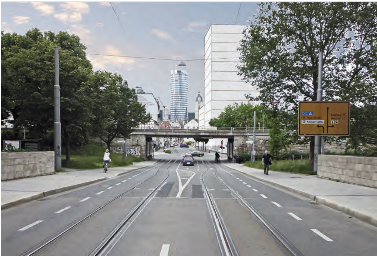
B Straßenansicht Camsdorfer Brücke, Blickrichtung Ost, Hochpunkt ca. 40m
