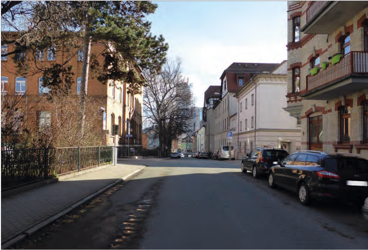
A Straßenansicht Semmelweisstraße, Blickrichtung Ost, Bestand
