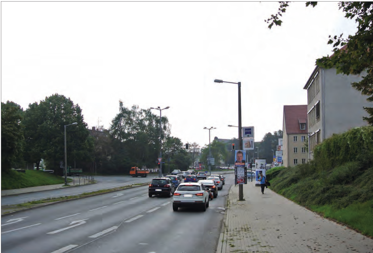
C2 Straßenansicht Wiesenstraße, Blickrichtung West, Bestand
