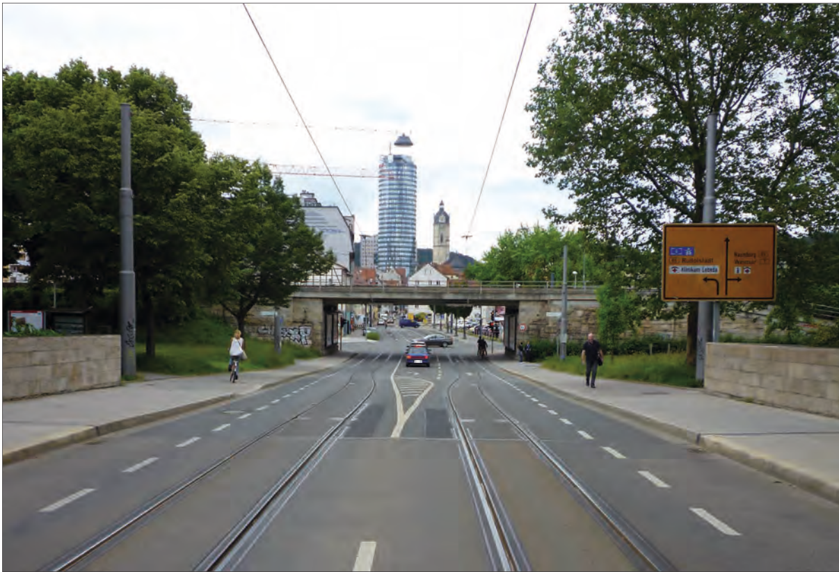
B Straßenansicht Camsdorfer Brücke, Blickrichtung Ost, Bestand
