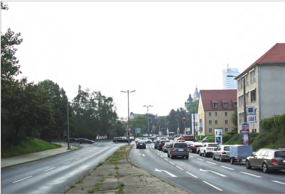
C1 Straßenansicht Wiesenstraße, Blickrichtung West, Bestand
