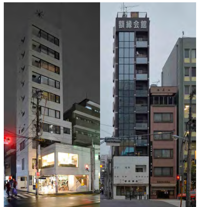
Abb. 9 Schlanke Hochhaustypologie in Tokyo
