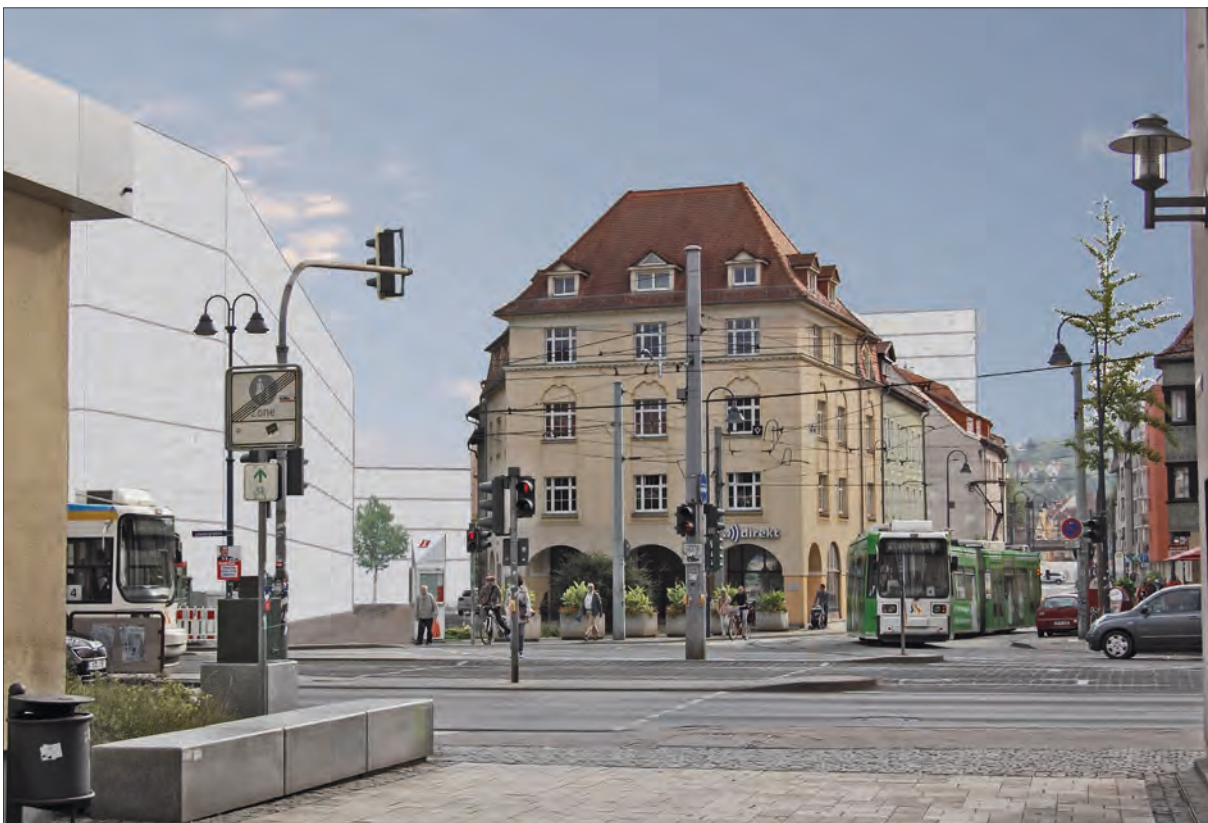
A Straßenansicht Saalstraße, Blickrichtung Ost, Hochpunkt ca. 40m, Hochpunkt nach Bebauungsplan, ca. 24m nicht sichtbar
